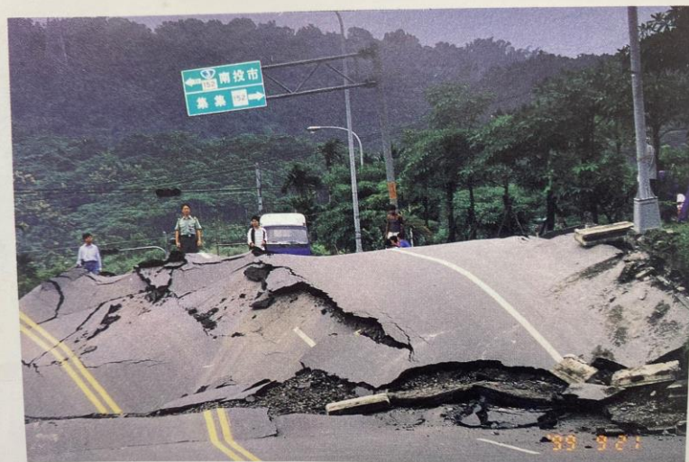
照片 5 南投縣名間鄉臺三線與投一五二號道路交叉口地面隆起情形。 (交通部國道新建工程局第五區工程處提供 88.9.21 攝)
